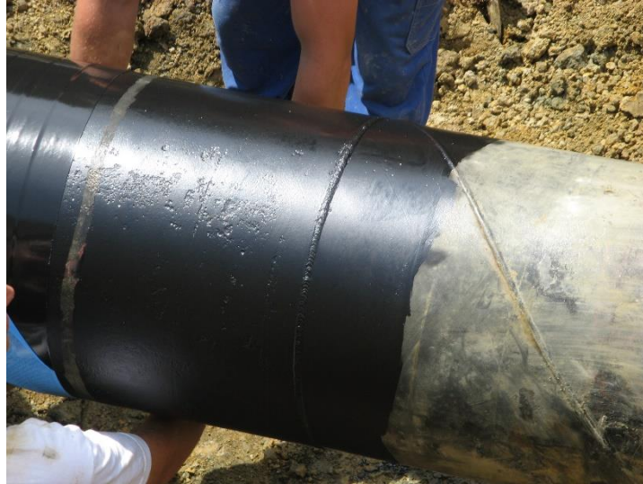
Slika 9.15 Postavljanje izolacijske trake [33]
