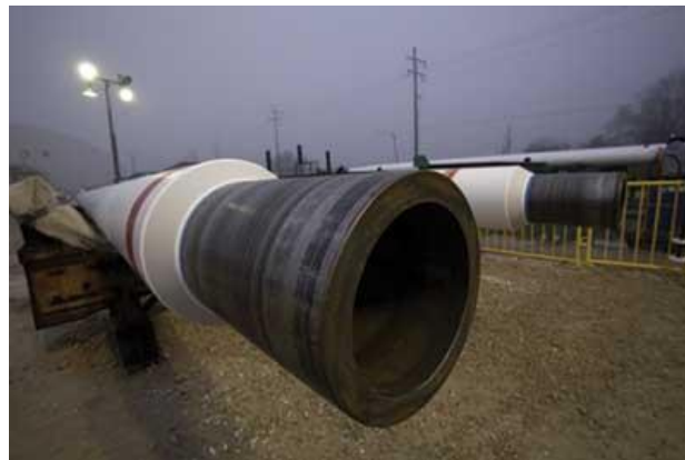
Slika 4.8 Kraj cijevi otežane betonskim prstenom [68]
