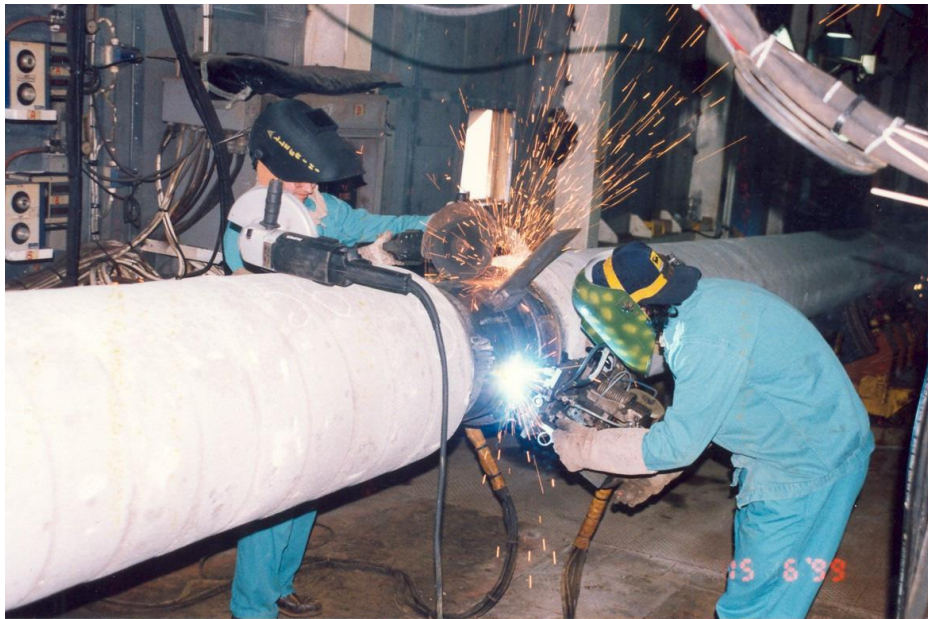
Slika 4.10 Zavarivanje plinovoda Platforma Ivana A – Platforma Garibaldi K [35]
