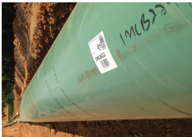
Slika 10.10 Označavanje zavara bar kodom i ručno upisanom oznakom [46]
