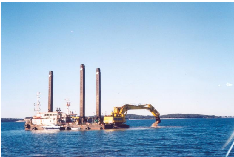
Slika 4.19 Kopanje rova u moru uz obalu za plinovod Platforma Ivana K – Pula [35]
