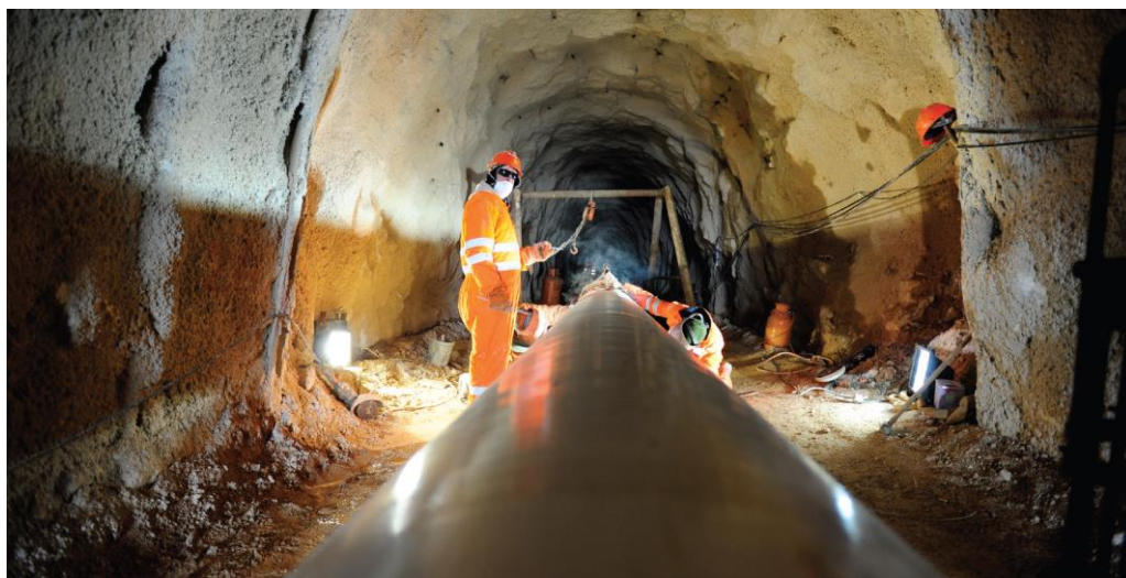
Slika 1.2 Izgradnja plinovoda Gospić – Benkovac (prijelaz ispod državne ceste D1) [33]
