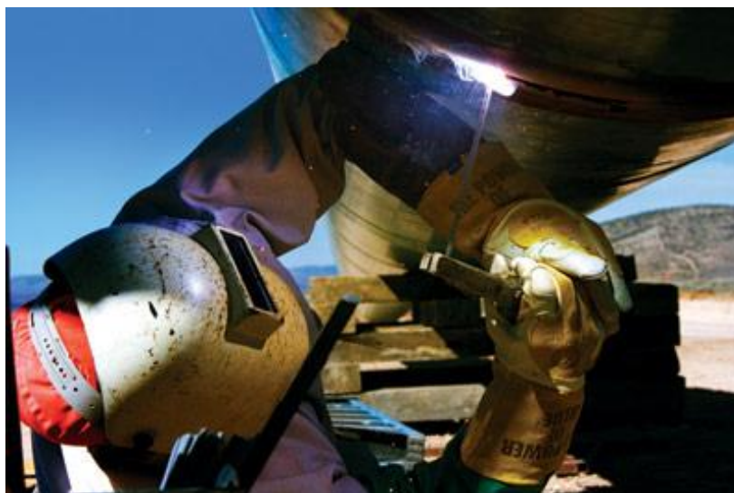
Slika 7.4 Zavarivanje cjevovoda [45]
