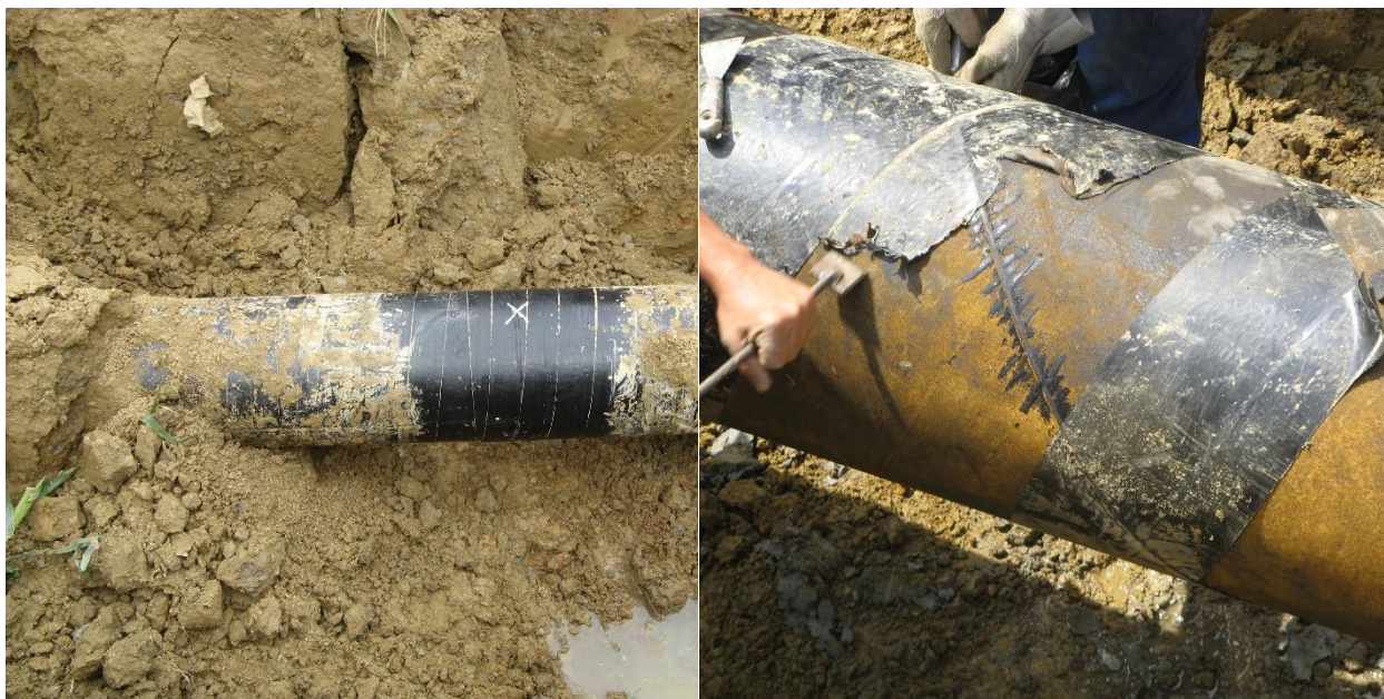
Slika 9.14 Iskopano mjesto oštećenja i skidanje izolacije [33]
