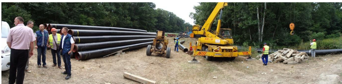
Slika 9.8 Priprema za ugradnju [33]
