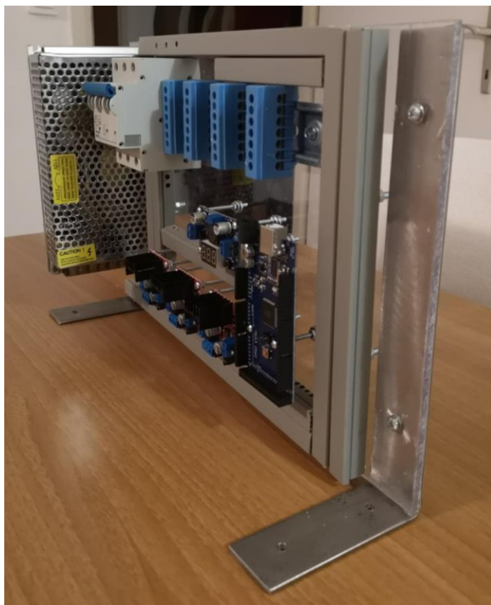
Slika 46. Upravljački ormar u procesu postavljanja komponenti
