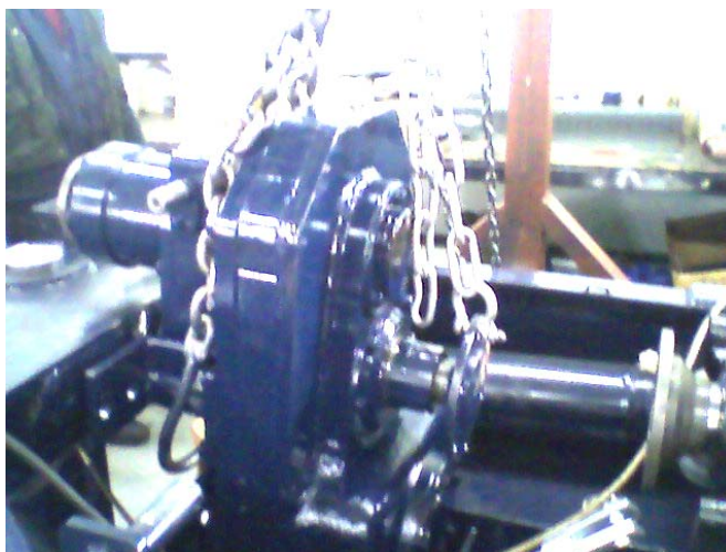
Slika 80: Motaža razvodnika pogona
