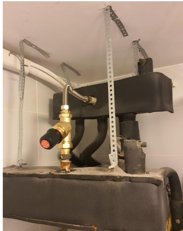
Slika 27. Ventil poslije zamjene
