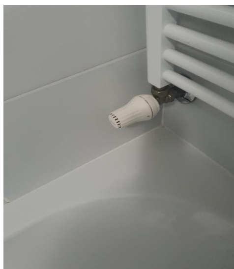
Slika 31. Zamijena novom termostatskom glavom
