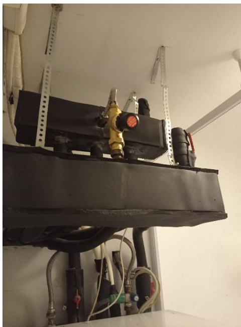
Slika 13. Ventil poslije zamjene
