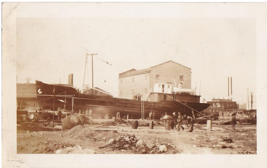
Slika 6. MS Carolinian, prvi komercijalni kompletno zavaren brod [5]
