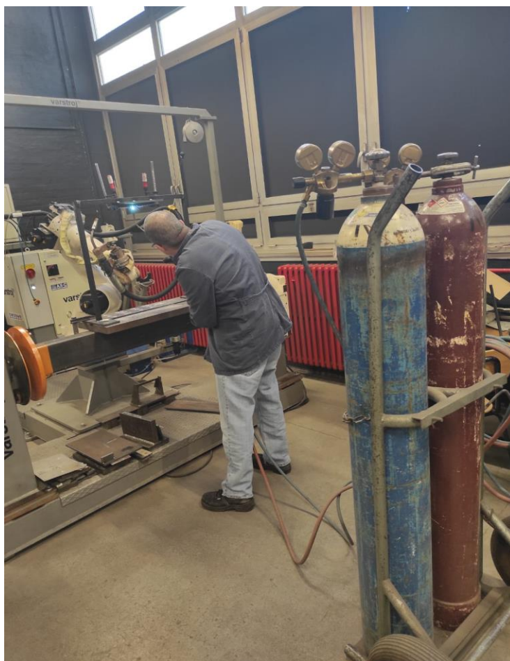
Slika 47. Predgrijavanje podloge i zida
