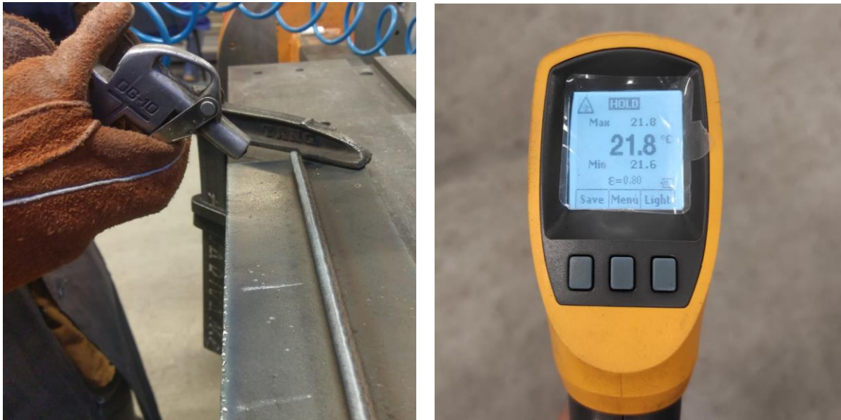
Slika 18. Hlađenje zida komprimiranim zrakom (lijevo) i uređaj za beskontaktno mjerenje temperature
