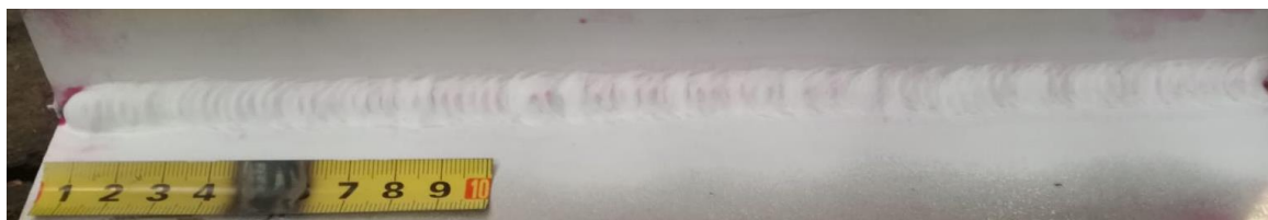
Slika 32. Zavar sa nanesenim penetrantom i razvijanjem
