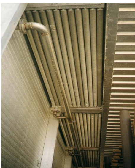
Slika 17. Prikaz ozmjenjivača topline unutar sušare [2]
