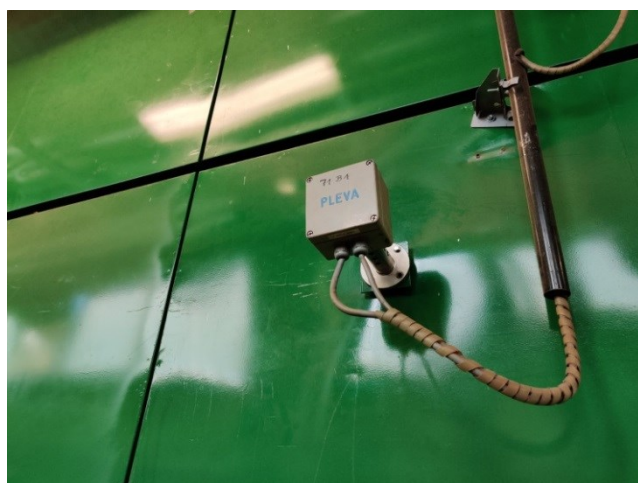
Slika 65. Senzor za očitavanje sadržaja vodene pare unutar sušare
