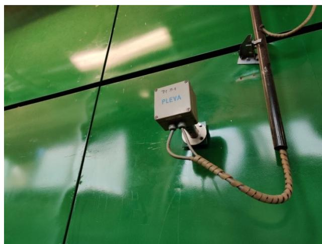
**Slika 65. Senzor za očitanje sadržaja vodene pare unutar sušare**
