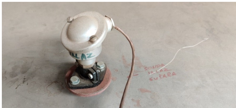
Slika 64. Senzor za očitavanje temperature unutar sušare – na bočnoj strani
