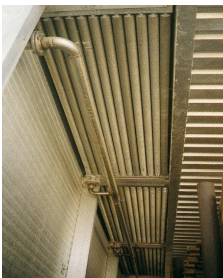
Slika 17. Prikaz ozmjenjivača topline unutar sušare [2]
