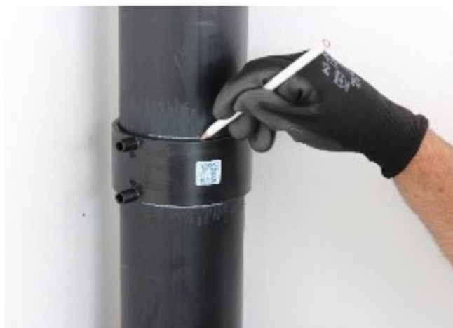
Slika 27. Označavanje mjesta na koje dolazi spojnica [20]
