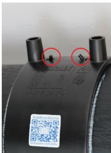
Slika 29. Izdignuti pipci na spojnici [20]
