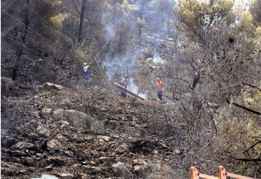
Slika 2-4-6-1 Radovi na opožarenom dalekovodu (izvor: Vjesnik Hrvatske elektroprivrede)
