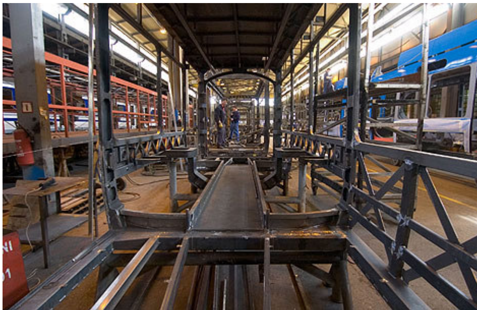
Slika 20: Izgled čelične konstrukcije donjih modula i bočnih stranica [20]
