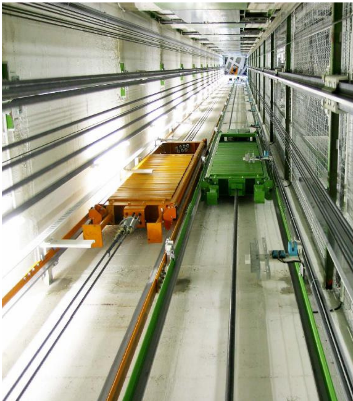
Slika 6.6. Vodilice i protutezi Twin liftova ThyssenKrupp
