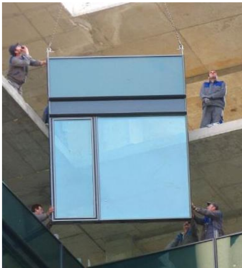
Slika 30. Element fasade pri ugradnji
