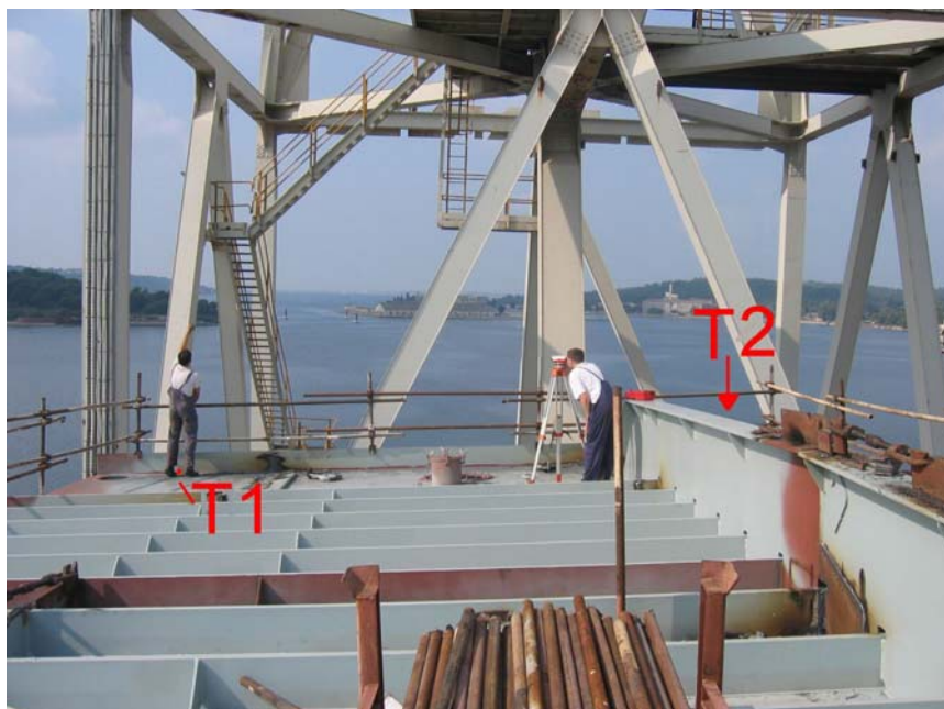
Slika 29: Kontrola uzdužnog nagiba sekcije
