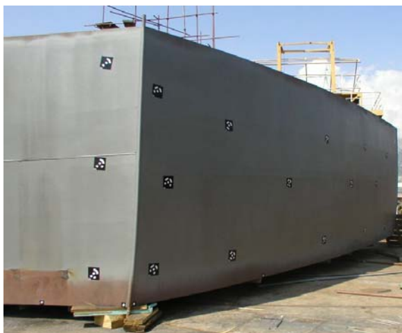
Slika 69: Postavljanje mjernih točaka na sekciji
