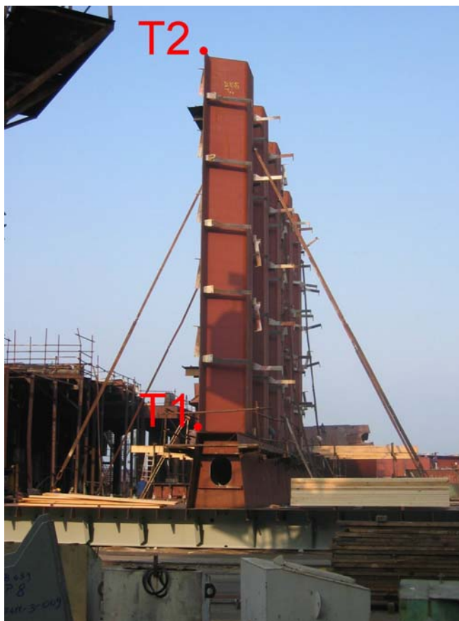
Slika 20: Kontrola okomitosti sekcije uzdužne pregrade
