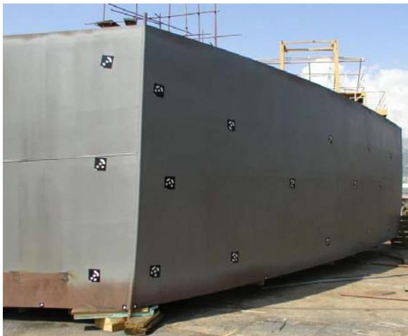
Slika 69: Postavljanje mjernih točaka na sekciji
