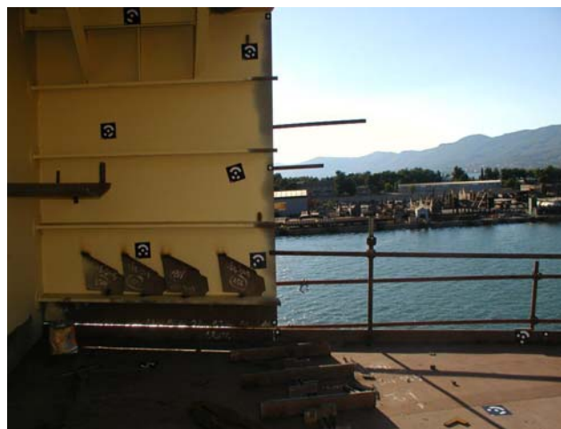
Slika 70: Postavljanje mjernih točaka na navozu
