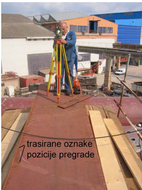
Slika 30: Postavljanje teodolita
