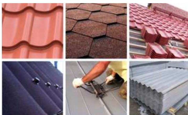
Slika 4. Različiti materijali krovnih pokrova[2]
