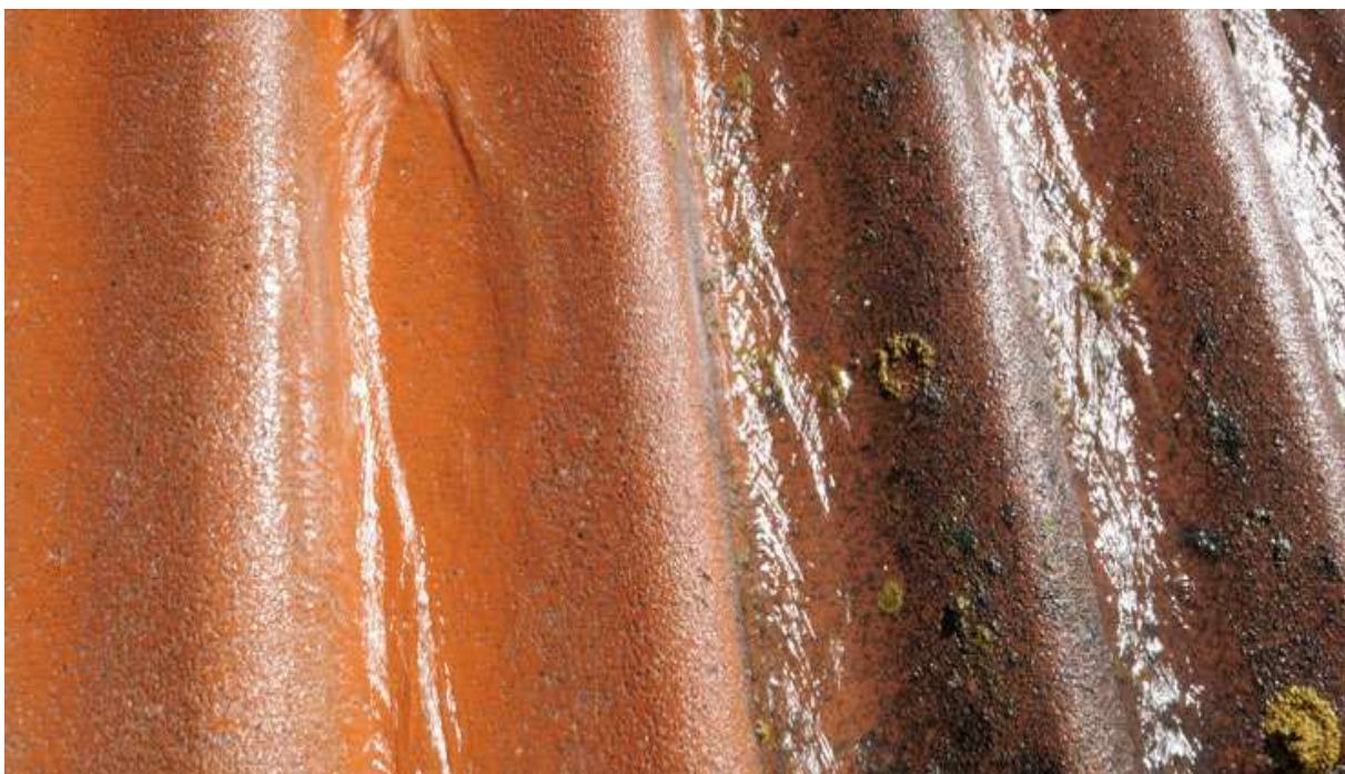
Slika 31. Površina očišćena Aqua Jet-om [17]
