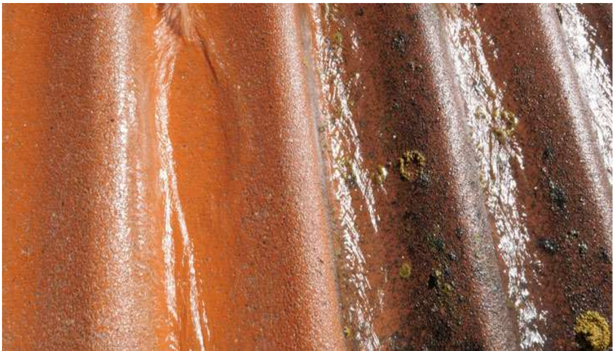
Slika 31. Površina očišćena Aqua Jet-om [17]
