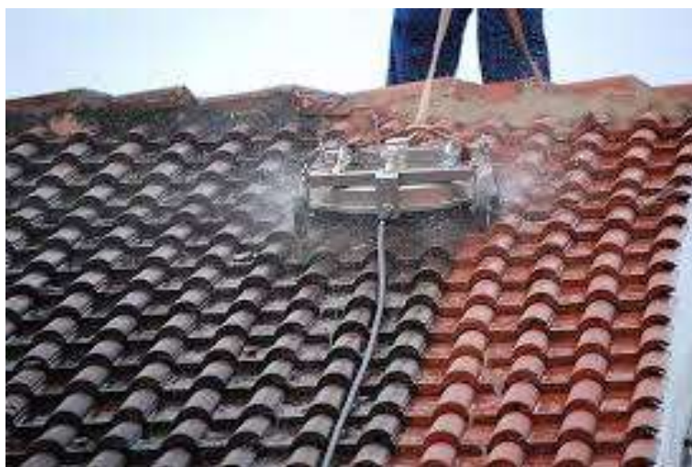
Slika 34. Mosmatic uređaj na glinenom pokrovu [18]
