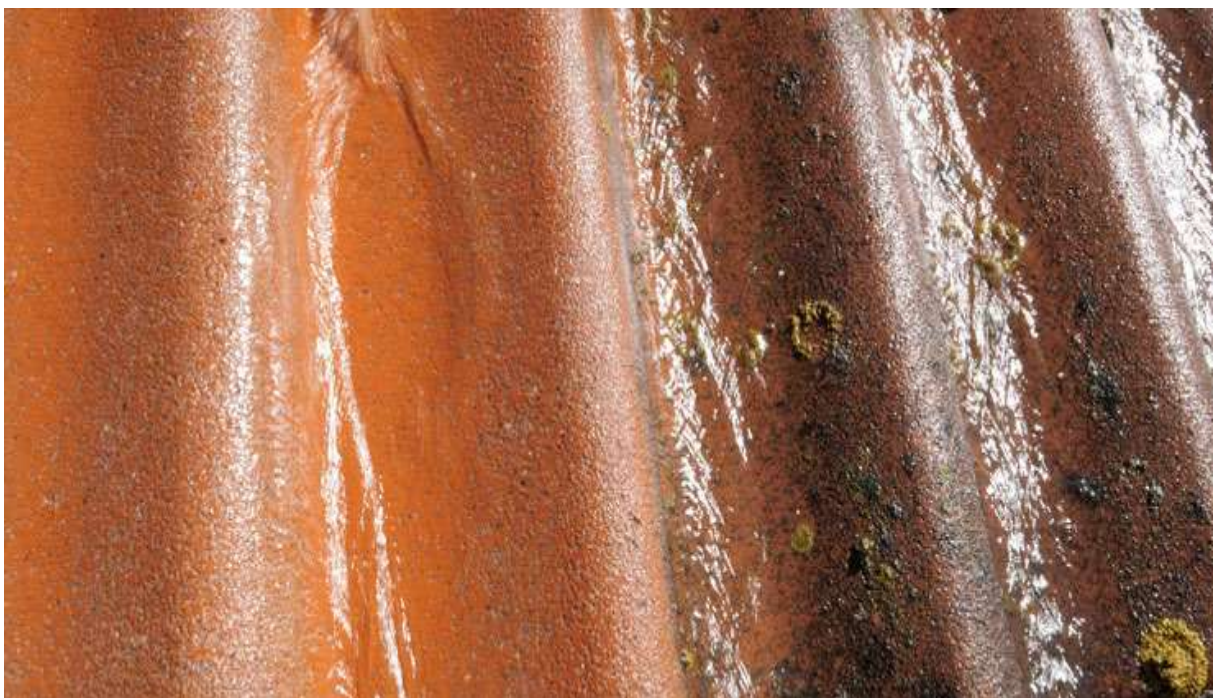
Slika 31. Površina očišćena Aqua Jet-om [17]
