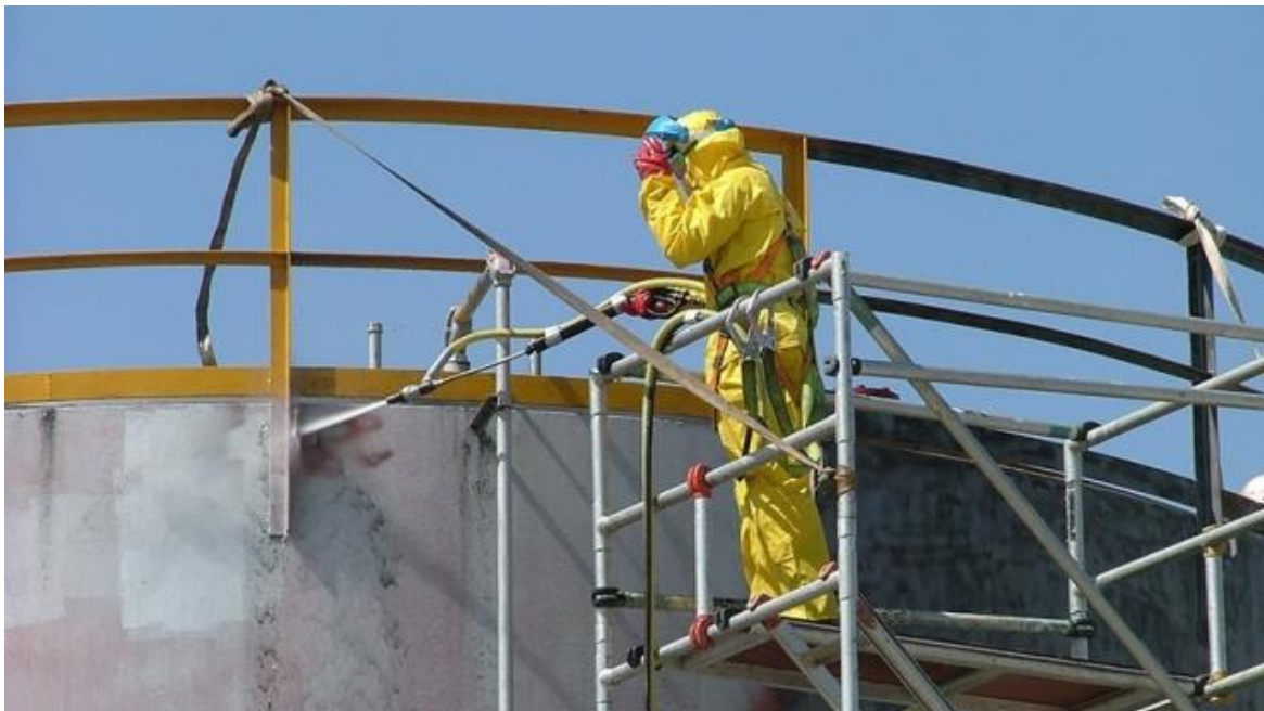
Slika 1.1. Zaštita čeličnih konstrukcija organskim premazima [3]
