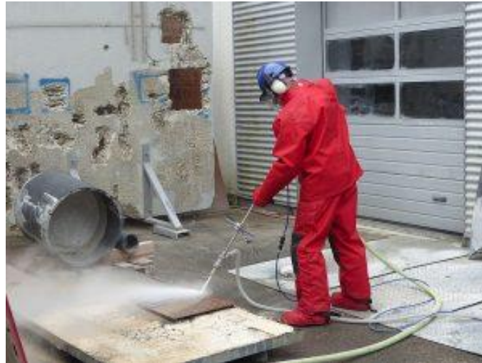
Slika 6.4. Čišćenje površine mlazom vode [27]
