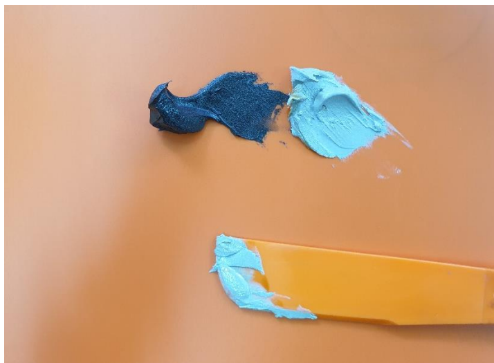
Slika 7.16. Određivanje potrebne količine komponenti Belzona 1212
