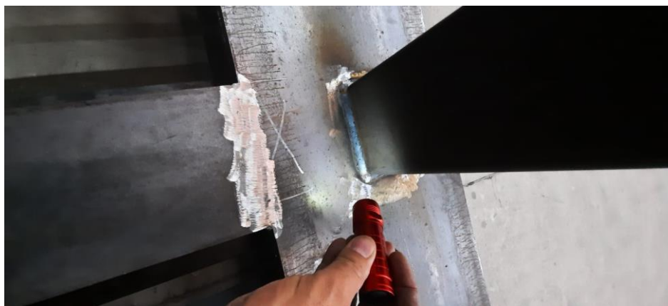
Slika 10. Vizualna kontrola zavara
