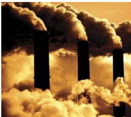
Slika 1. Ispuštanje štetnih plinova u atmosferu
