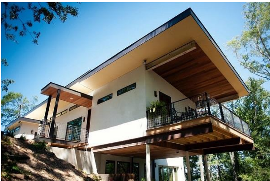
Slika 9.13. Prva kuća izgrađena od konoplja i betona u SAD-u [82]
