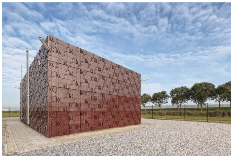
Slika 9.9. Fasada stanice za prihvat plina [80]
