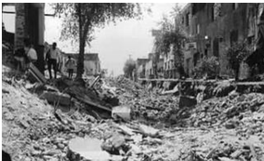
Slika 14. Eksplzija kanalizacionog sustava u Guadalajari 1992. g. [15]
