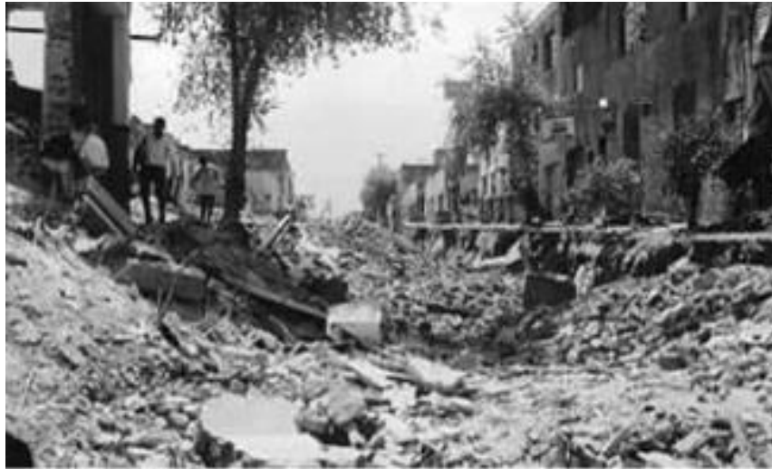
Slika 14. Eksplzija kanalizacionog sustava u Guadalajari 1992. g. [15]
