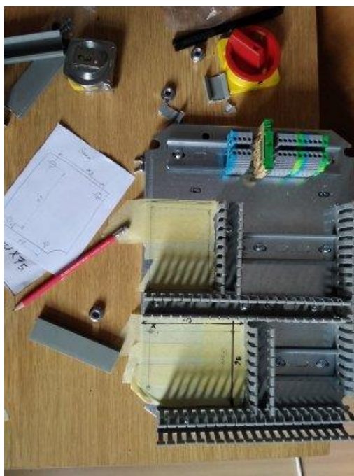
Slika 29. Montiranje uzdužnih kabelskih kanala
