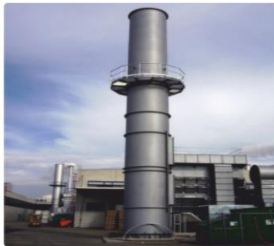
Slika 7. Primjer korištenja silikonskih smola u zaštiti industrijskih dimovoda [7]
