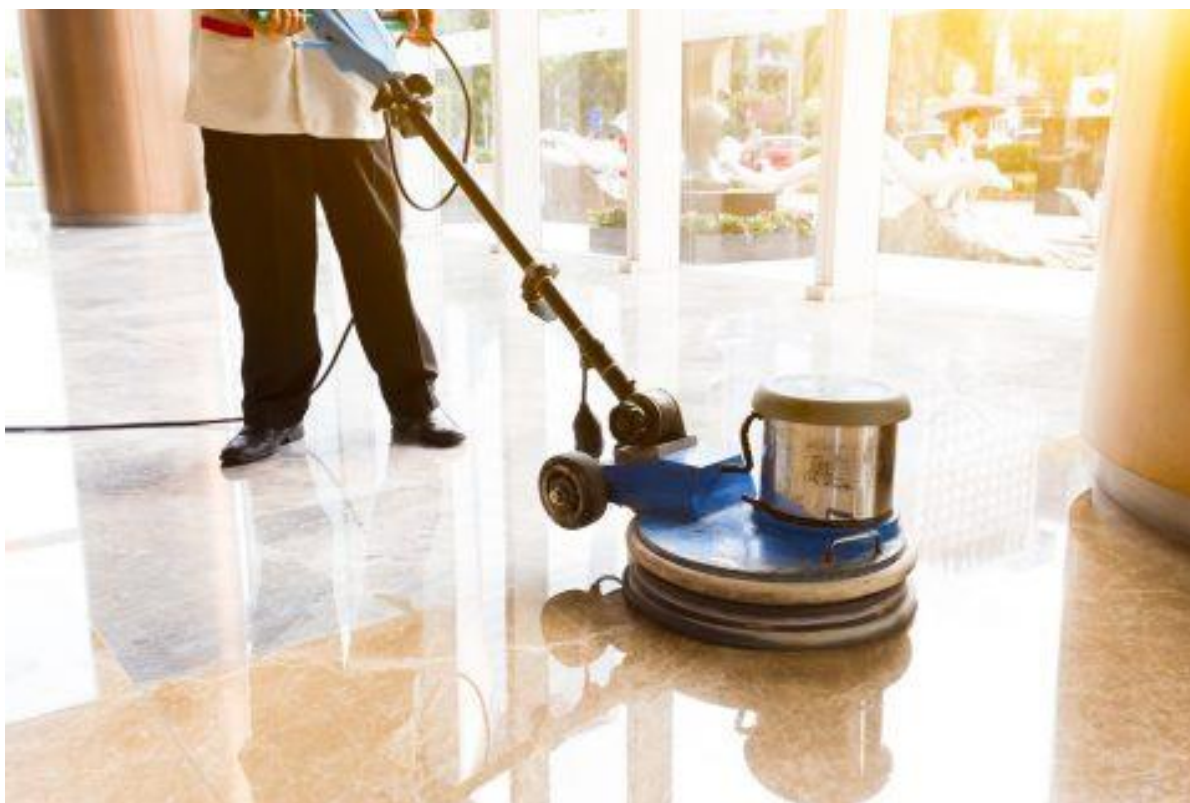
Slika 2. Laštenje granitnog poda [2]
