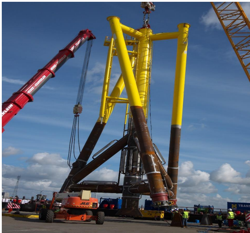
Slika 13. Primjer uvijenih temelja [12]
