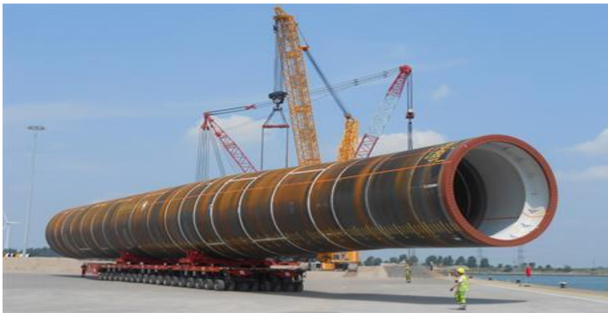
Slika 9. Primjer jednostupnih temelja [8]
