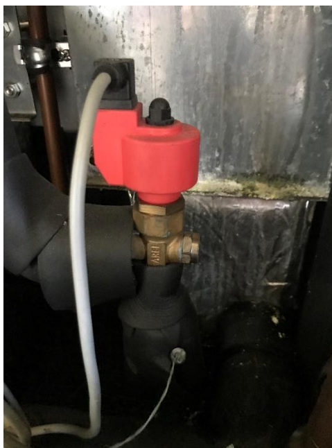
Slika 16: Elektronički ekspanzijski ventil
