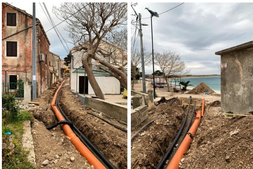
Slika 16. Proces izgradnje vodovodne i kanalizacijske mreže [44]
