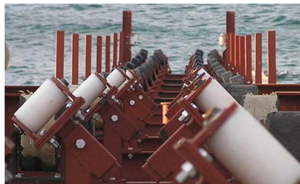
Slika 2.10 Postolje za ulaz cijevi u more
