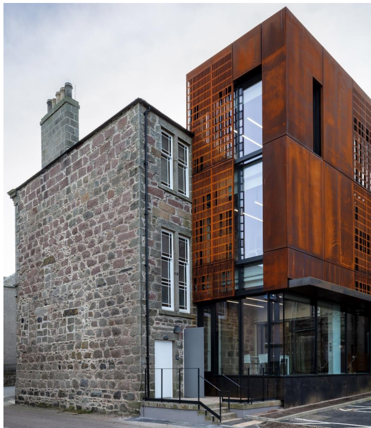
Slika 20. Corten čelik kao obloga zgrade, Škotska [32]
