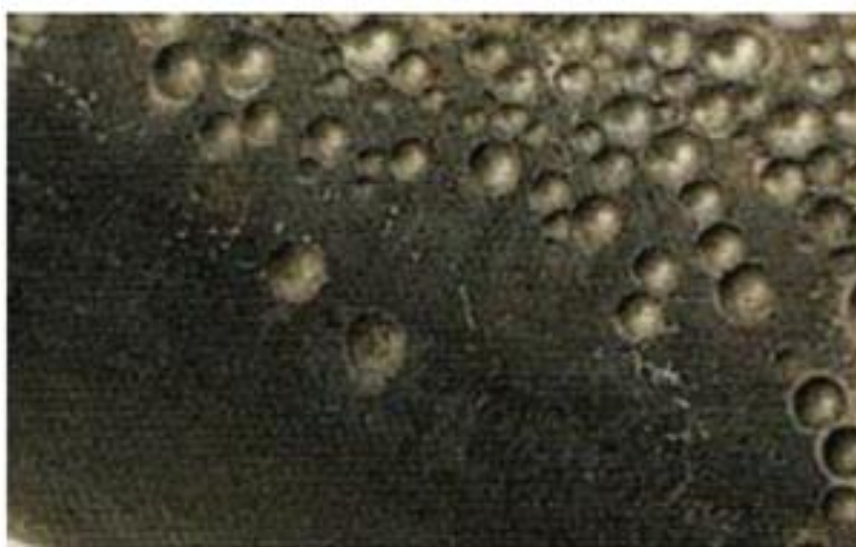
Slika 5. Pojavni oblik rupičaste korozije na titanovoj leguri [11]
