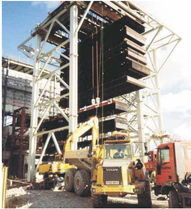
1.12. Vertikalni tip generatora pare na otpadnu toplinu u izgradnji
