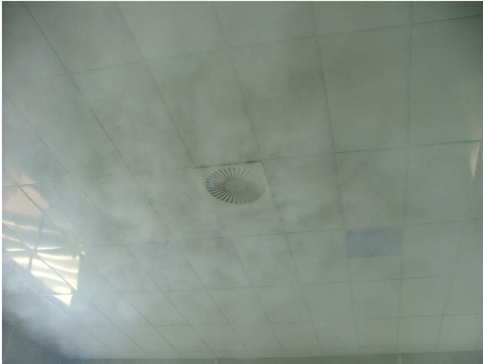
Slika 5.10 Priljubljenje mlaza uz strop kod ploče difuzora s prstenom
