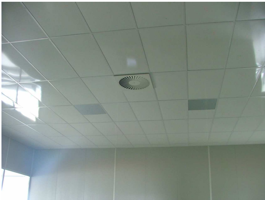
Slika 5.6 Difuzor u centralnom dijelu stropa prostorije
