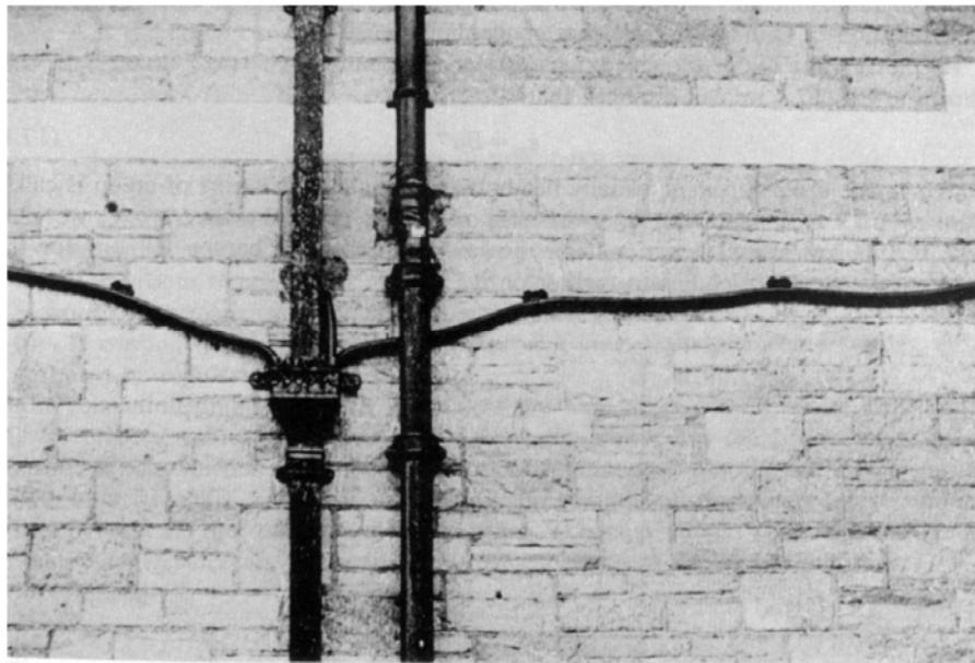
Slika 12. Puzanje olovnih cijevi pri sobnoj temperaturi [55]
