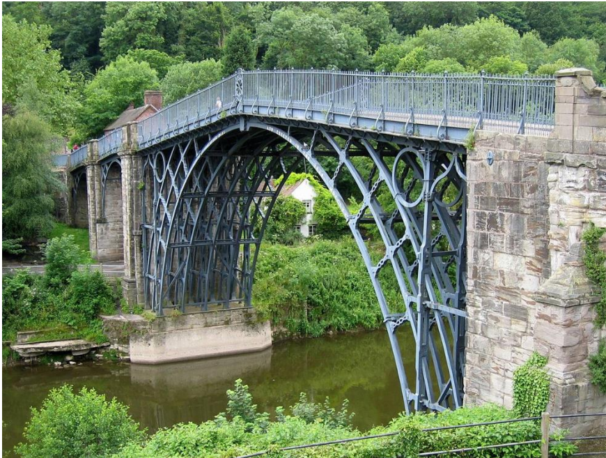
Slika 1.5. Prva nosiva konstrukcija od željeza u svijetu [5]
