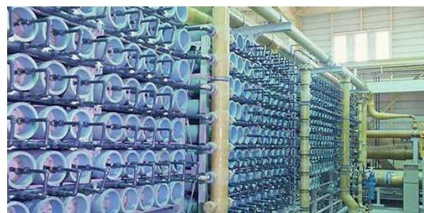
**Slika 10. RO moduli u postrojenju za desalinizaciju**
