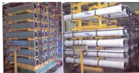
**Slika 9. RO moduli u postrojenju za desalinizaciju**
