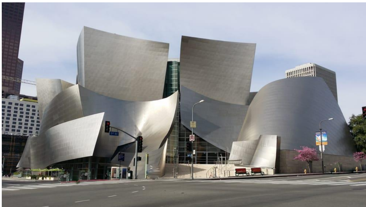
Slika 41. Građevina kompleksne geometrije izrađena pomoću virtualnih tehnologija
