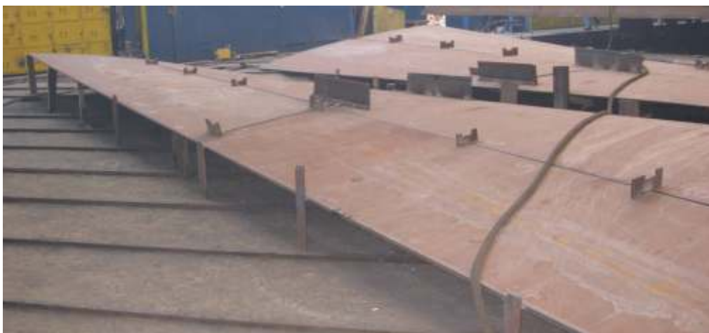
Slika 35. Pozicionirani limovi vanjske oplata na radnoj platformi radionice
