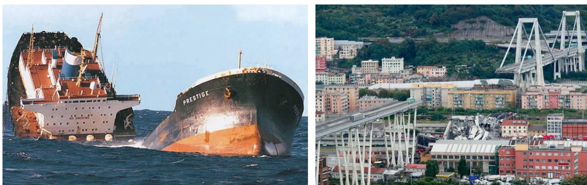
Slika 1. Primjeri šteta uzrokovanih korozijom – brodolom tankera Prestige i urušavanje mosta u Genovi [2,3]
