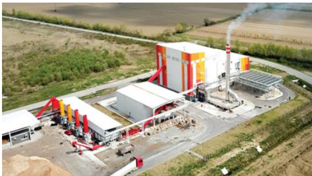
Slika 2.2. Kogeneracijska termoelektrana u Slatini
