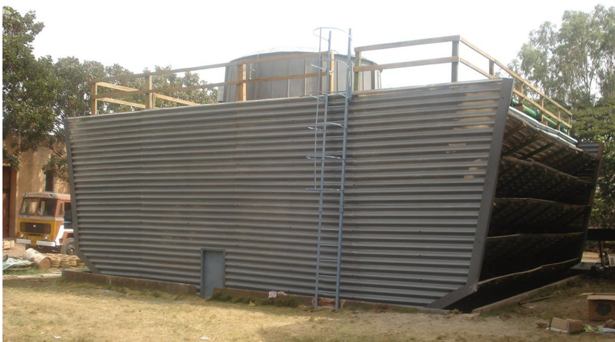
Slika 12. Rashladni toranj izrađen od drveta
