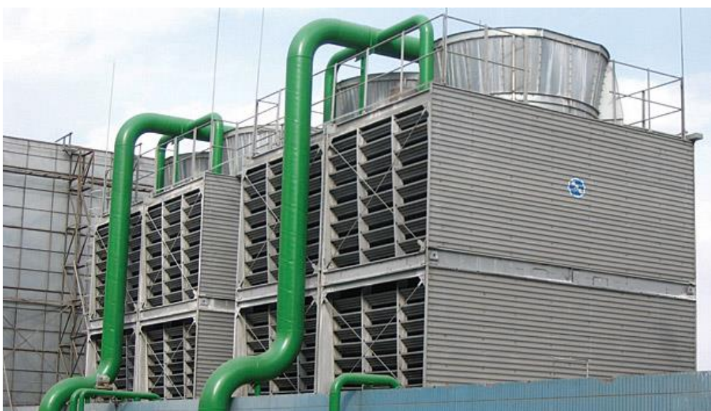
Slika 13. Rashladni toranj izrađen od galvaniziranog čelika
