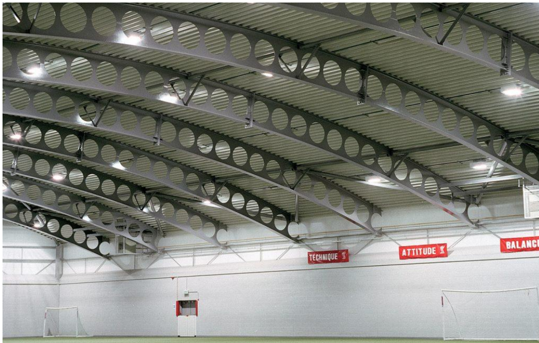
Slika 3. Krovni I - profili s otvorima [4]
