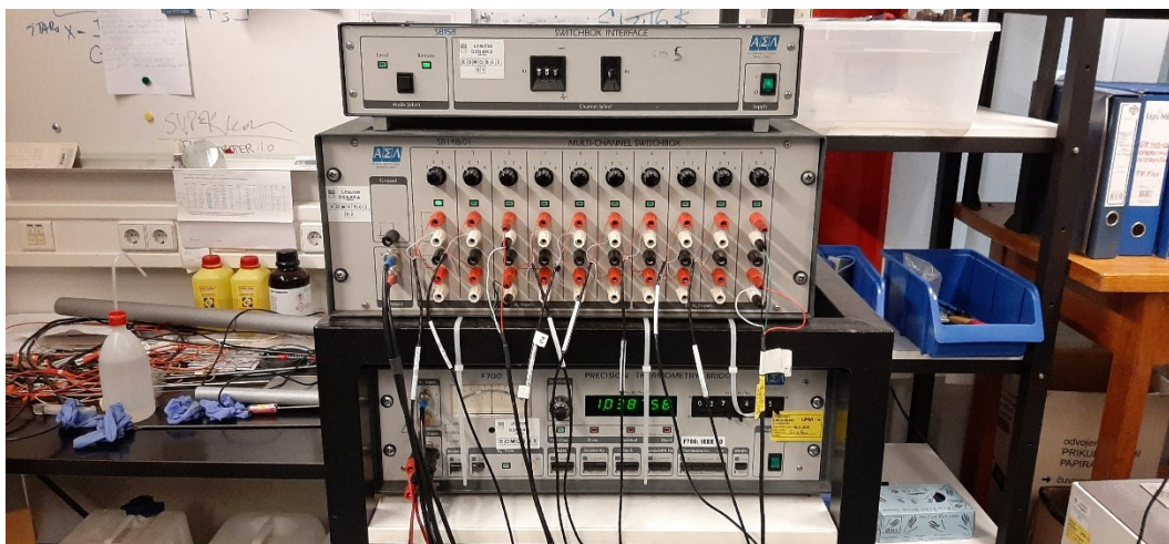
Slika 2 Mjerna postaja – Multipleksor s upravljačkom jedinicom i otporničkim mostom
