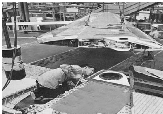
Slika 2.5 Pregled spornog dijela konstrukcije prizemljenog zrakoplova
