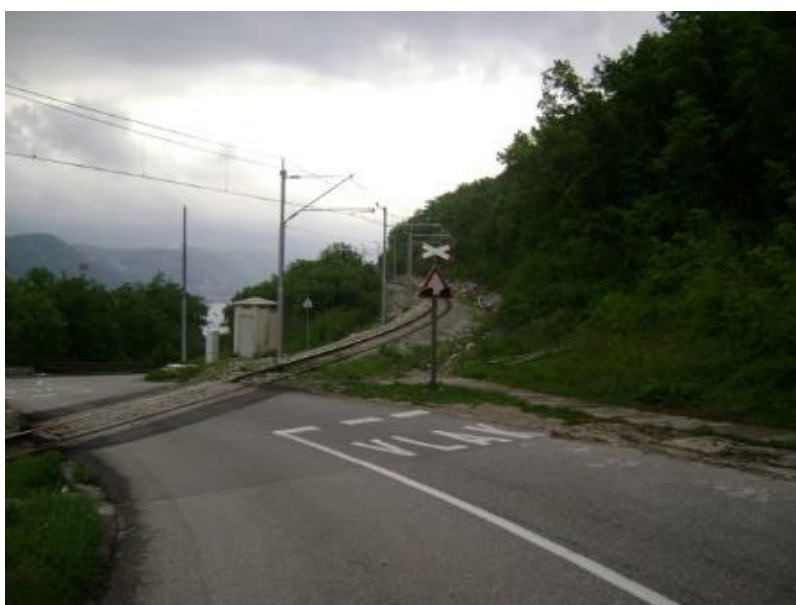
Slika 1 Prijelaz zaštićen znakovima i svjetlosnim signalima [2]
