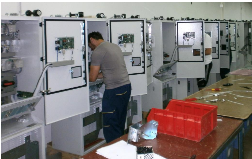
Slika 36. Montaža konačnog proizvoda [22]
