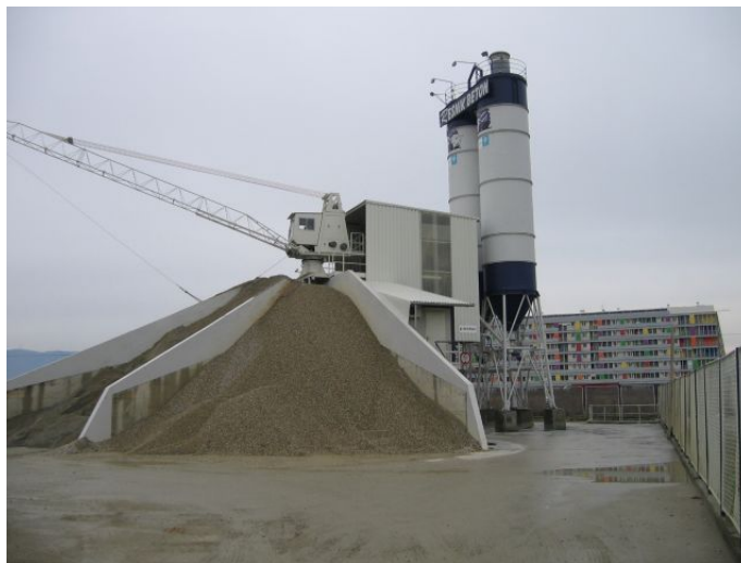
Slika 1. Betonara tipa „zvijezda“
