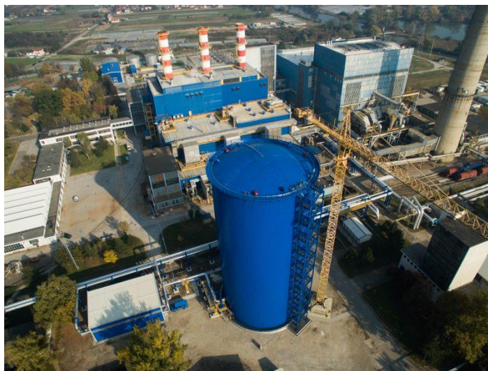
Slika 5. Kratkoročni spremnik topline u TE-TO Zagreb [7]
