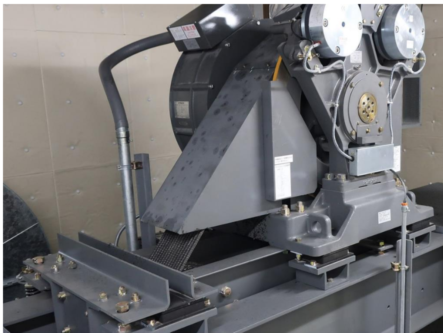
Slika 1. Čelična užad i elektromotor kao pogon užetnog dizala
