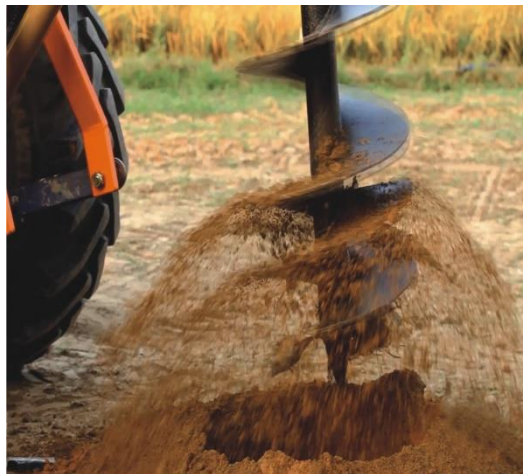
Slika 4. Bušenje rupa primjenom priključaka pogonjenih strojem
