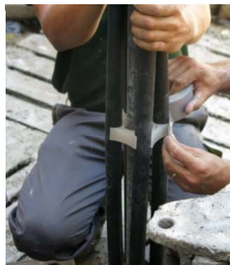
Slika 4-2 Poprečni presjek bušotinskog izmjenjivača topline (lijevo) i prikaz izmjenjivača s odstojnikom prilikom ugradnje (desno)
